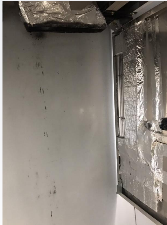
Bọc bảo ôn hệ thống điều hòa
